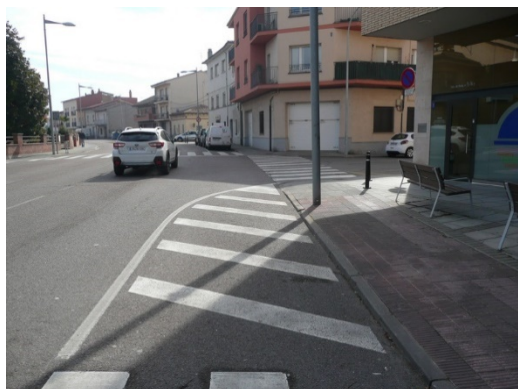
Imatge 75. Orella abans del gir però on s'ha desplaçat el pas. És un cas millorable a la carretera de Roda amb el carrer Sescorts.
