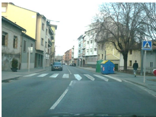
Imatge 102. Reductor de plataforma elevada al pg. de Sant Joan.
