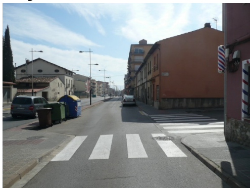
Imatge 32. Entre aquest punt i el tram següent canvia el costat d'aparcament per a establir zig-zaga.
