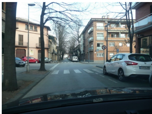
Imatge 85. Aparcament obstructiu de visibilitat. Carrer de Santiago Rusiñol amb carrer de les Hortes.
