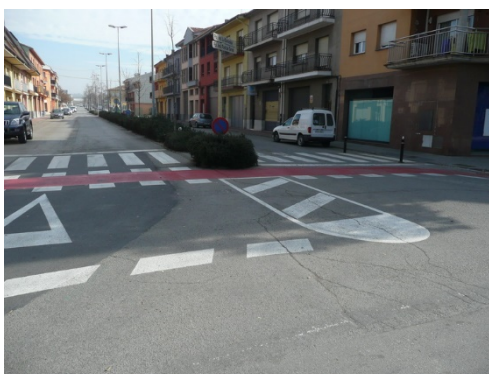
Imatge 4. Prolongació de la mitjana en la rotonda de pl. Sardana.
