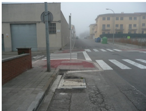
Imatge 8. Detall d'una de les 4 orelles noves construïdes.
