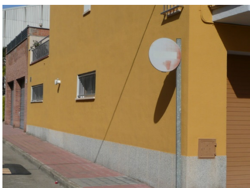
Imatge 43. Senyal al Torrent Garriga que ha perdut gairebé del tot les propietats de color.
