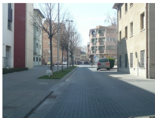
Imatge 67. Paviment únic al carrer de Bellfort.
