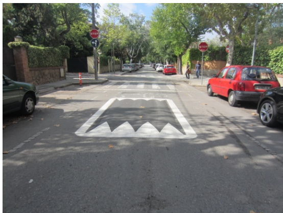
Imatge 57. Exemples de coixins berlinesos d'asfalt.
