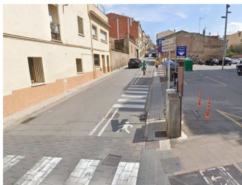
Imatge 49. Exemple de vorera addicional sobre l'espai de calçada a Caldes de Montbui.
