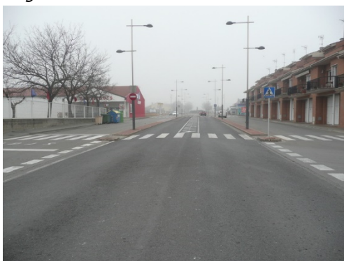
Imatge 38. Centre de la cruïlla, sense marques.
