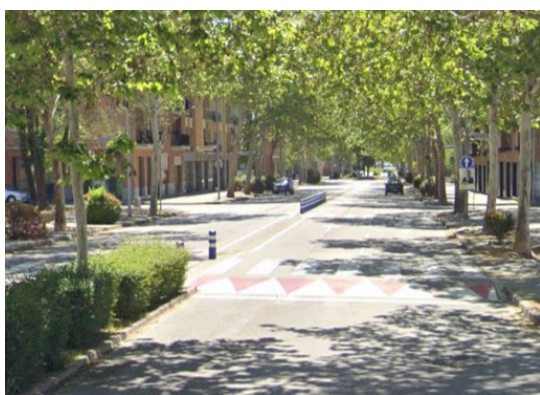
Imatge 53. Pas de vianants elevat a l'altura del Centre Cívic.
