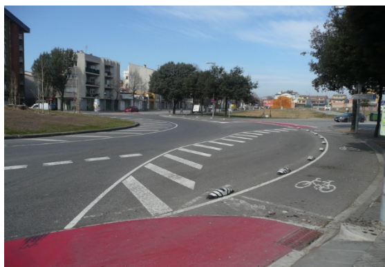
Imatge 13. Recreixement d'espai entre ramals.
