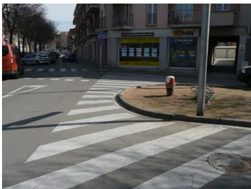
Imatge 28. Accessibilitat deficient i refugi deficient també per al vianant que travessa.
