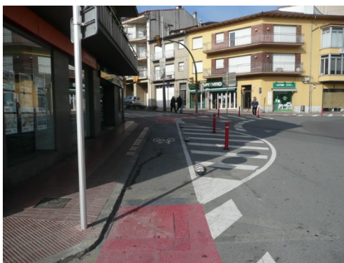
Imatge 2. Reforma executada a la intersecció de l'av. de Roma amb el passeig de Sant Joan.
