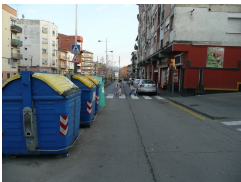
Imatge 15. Contenidors abans del pas de vianants. Obstrueix la visibilitat.
