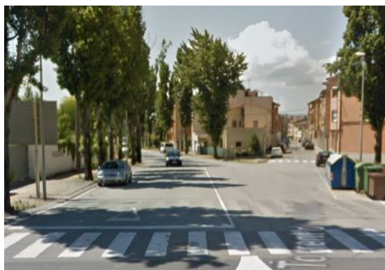
Imatge 11. Situació prèvia a la reforma del Torrent de la Borina.
